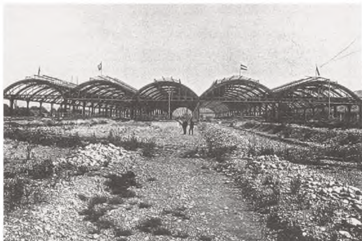
Abb. 2.9. Bahnsteighallen des Personenbahnhofs im Rohbau fertig (Anonym, 1914)
