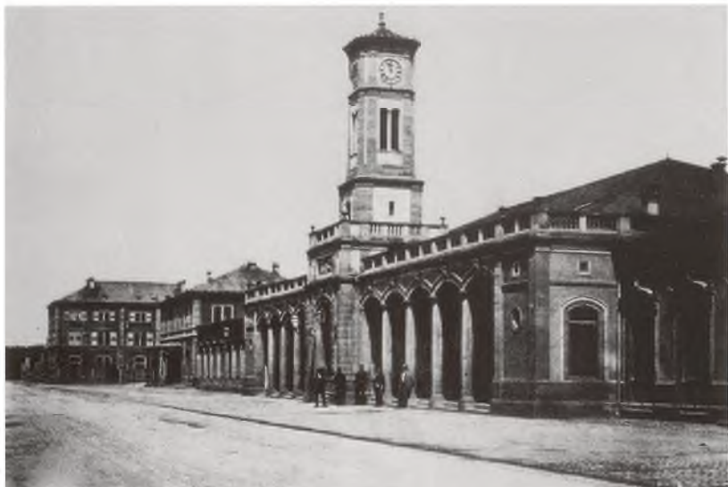
Abb. 2.2. Erster Badischer Bahnhof am Riehenring, neobarock, 1859–1862 vom grossherzoglichen Baurat Berk Müller anstelle des Provisoriums von 1855 erbaut (Brönnimann, 1973).
