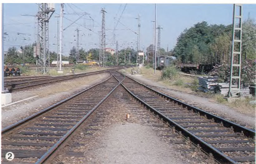
Tafel 1. 1. Sektor 1, Badischer Bahnhof, Südteil, Blickrichtung NW, 23.8.2001 (Foto A. Coray). – 2. Sektor 2, Badischer Bahnhof, Nordteil, Blickrichtung NW, 23.8.2001 (Foto A. Coray).
