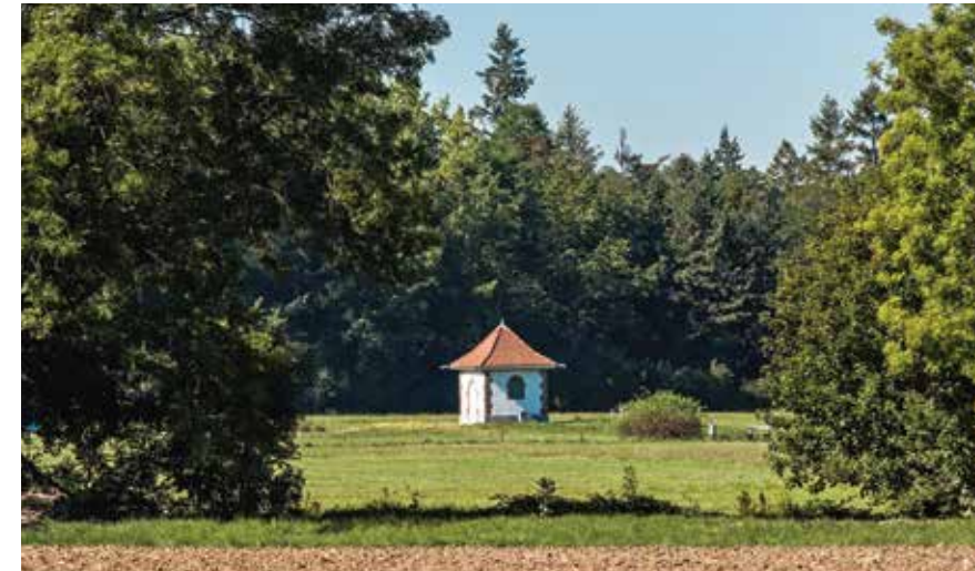
Grösstenteils unsichtbar, prägt die Trinkwassergewinnung dennoch stark das Landschaftsbild im Landschaftspark Wiese: Brunnenhäuschen in den Stellimatten.
